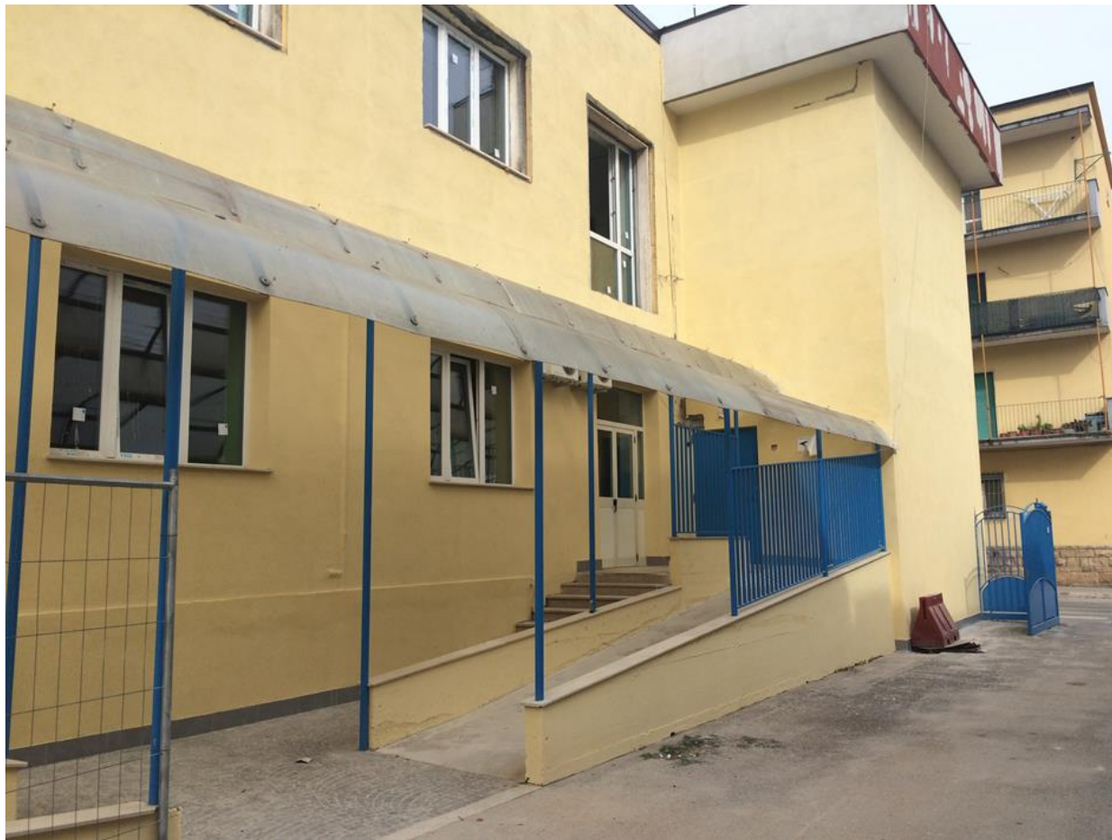
Vista fotografica della rampa di ingresso al micro-nido
